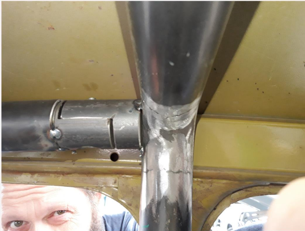
Verstärkung der A- und B-Säule mittels Aussteifungsrahmen durch Fa Fischerleitner
